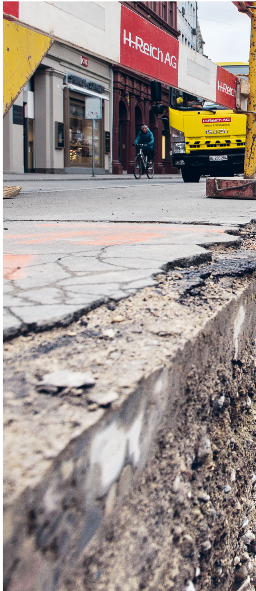
ABB. 16 Tonplattenboden von Gebäude G. Foto: Philippe Saurbeck.
