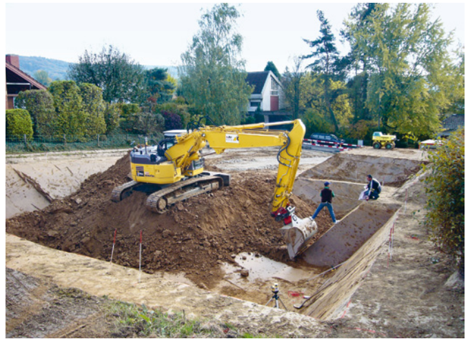
Abb. 51 Blick in die Baugrube. Foto: Christoph Matt.
