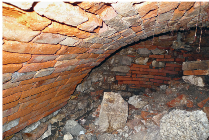
Abb. 10 Unterirdischer Raum mit Gewölbe aus Backsteinen, verfüllt mit Abbruchschutt. Foto: Sven Straumann.
