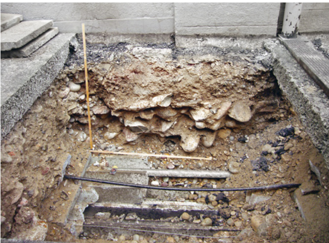
Abb. 43 Blick auf die Reste des hinteren (inneren) Turmfundamentes. Foto: Christoph Matt.
