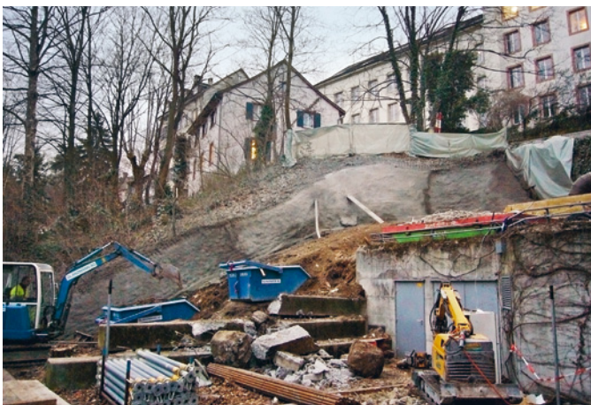
Abb. 29 Blick über die Baustelle östlich des langgezogenen Fabrikgebäudes am Fusse des Talhangs unmittelbar neben dem Gewerbekanal (dem «Dalbedyck»: links hinter dem Bagger, nicht sichtbar). Foto: Christoph Matt.
