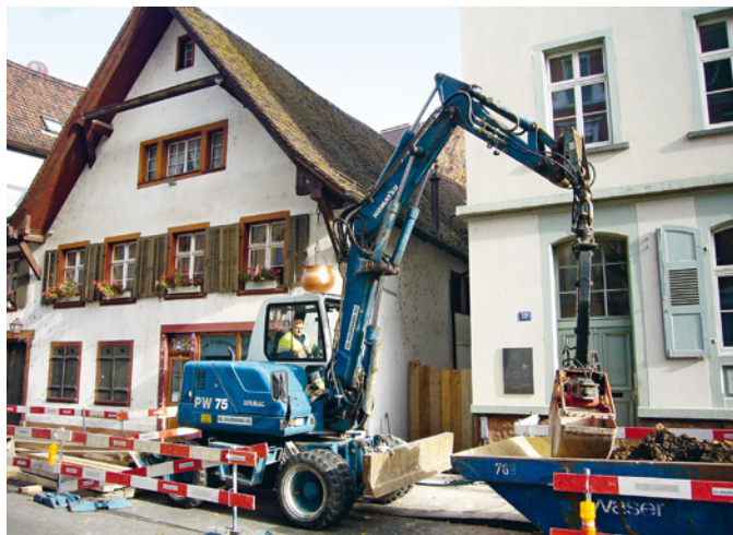
Abb. 41 Blick auf die Baustelle zwischen den Häusern Nr. 12 (rechts) und 14 (links). Foto: Christoph Matt.
