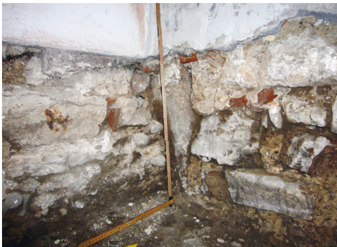
Abb. 36 Westlicher Seitenflügel: Blick nach Nordosten in die Ecke zwischen ältester Mauer (Hoffassade; rechts) und anstossender nördlicher Mauer (links). In der Ecke hinter dem Doppelmeter der zur ältesten Mauer gehörende senkrechte Türgewändestein. Foto: Christoph Matt.
