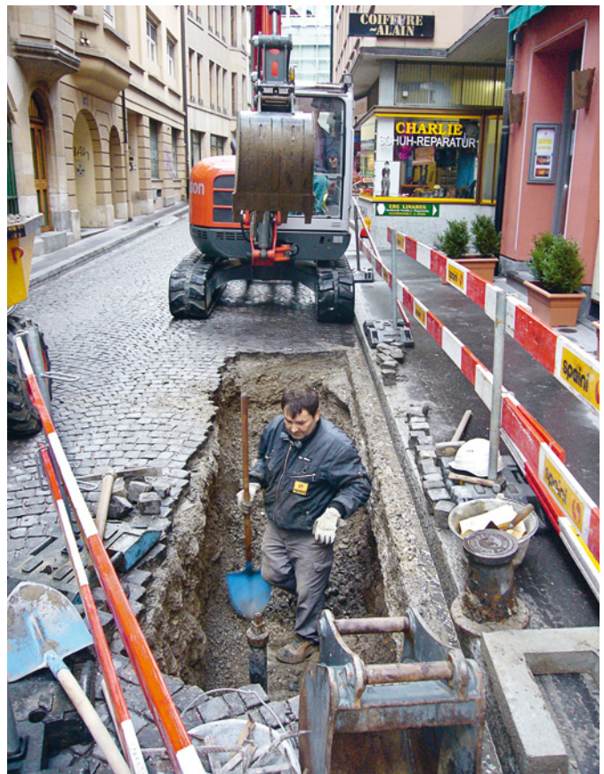
Abb. 30 Blick über die Baustelle. Foto: Christoph Matt.
