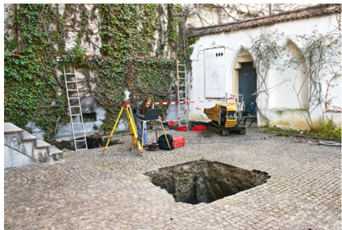
Abb. 11 Archäologische Untersuchung der Fundamentgruben für den Baukran. Foto: Michael Wenk.
