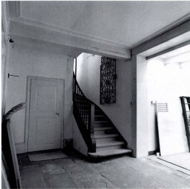
Abb. 10 Überbauter Hof unmittelbar anschliessend an das Vorderhaus. Im Hintergrund die Treppe, welche in den umgewandelten Hofflügelbau integriert ist. Der Unterzugsbalken über dem Treppenantritt markiert die Fassadenflucht des Hofflügelgebäudes. Die davorliegende Überdeckung des Treppenhausvorplatzes stammt – wie die Treppe – aus dem 19. Jahrhundert, die Decke über dem Hof ganz rechts entstand 1943. – Foto: Basler Denkmalpflege.
