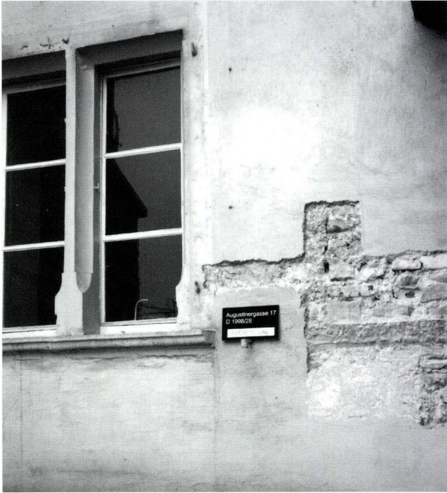
Abb. 19 Vorderhaus, Hoffassade 2. OG: Originalfenster von 1363. Rechts daneben der urspr. durchgehende, später teilweise abgeschlagene Gesimgurt, auf dem die Fenster aufruhon. Das zweiteilige Fenster ist in Sandstein eingefasst, die Kanten haben eine Kehle, eine abgesetzte Schaufel vermittelt zum Sockel. Die vorstehende Fensterbank sockelt auf einem viertelgerundeten Wulst, welcher oben und unten in eine feine Kehle übergeht. Wahrscheinlich besass der gesamte Gesimgurt dieses Profil. – Foto: Basler Denkmalpflege.
