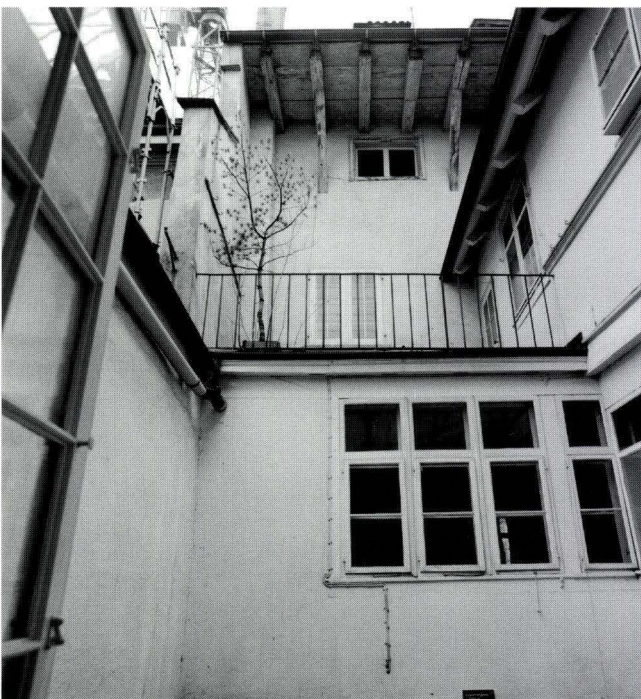
Abb. 8 Hoffassaden des Vorderhauses, des Terrassenausbaus im 1. OG sowie des seitlichen Hofflügelgebäudes (rechts). Die weit ausragenden Dachbalken des Vorderhauses werden im Bereich der Binder durch Bughölzer gestützt. Seitlich an die Hoffassade ist der Hofflügelbau mit tieferer Dachtraufe angefügt. Erkennbar sind Teile der Obergeschossfassaden mit leicht vorkragendem oberstem Stockwerk. Als Querriegel nachträglich eingeschoben der Terrassenausbau. – Foto: Basler Denkmalpflege.
