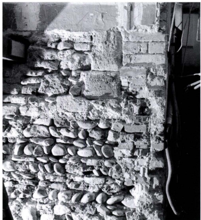
Abb. 17 Ansicht der Kellermauer des Vorderhauses von der (ausgehobenen) Hofseite her. In der Mitte oben ist der Ansatz der Schwelle mit aufsitzendem Gewände des urspr. Kellerportals deutlich zu erkennen. Die Schwellenhöhe liegt 30–40 cm unter dem heutigen EG-Boden. Vom Kellerportal, das zum Originalbestand des «Kleinen Markgrafenhofs» (um 1360) gehört, sind das Seitengewände sowie der Rundbogen noch erhalten. Die Öffnung dient weiterhin als Kellereingang. – Foto: Basler Denkmalpflege.
