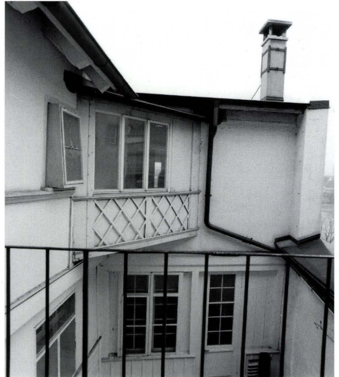
Abb. 11 Ecke zwischen Hofflügel und Hinterhaus. Die Erschliessung des Hinterhauses führt über eine nachträglich angefügte «Brücke», welche einem Badzimereinbau im Hofflügel ausweichen muss. – Foto: Basler Denkmalpflege.
