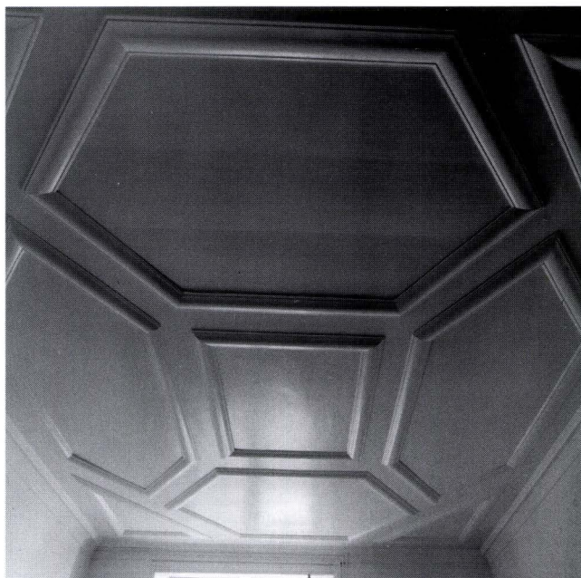
Abb. 5 Vorderhaus, EG: Raum mit barocker Täferdecke. – Foto: Basler Denkmalpflege.
