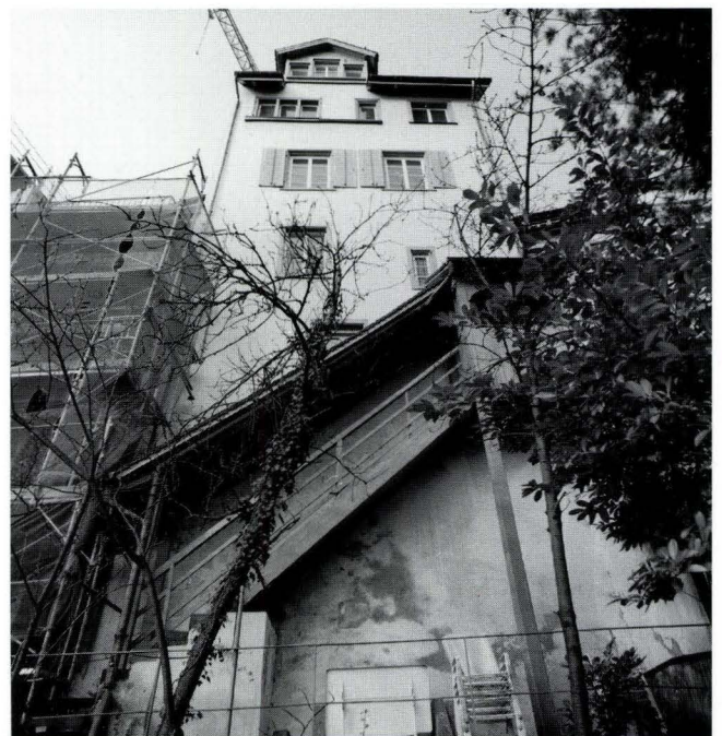
Abb. 12 Hinterhaus, Rheinfassade. Im Vordergrund die an die Hangmauer angefügte Aussentreppe zur unteren Rheinterrasse. Die beiden von der Aussentreppe an aufgehenden Geschosse sind vom Innenhof her Untergeschosse. Darüber liegen zwei Vollgeschosse sowie das mit einer grosszügigen Gaupe 1897 ausgebaute Dachgeschoss. – Foto: Basler Denkmalpflege.
