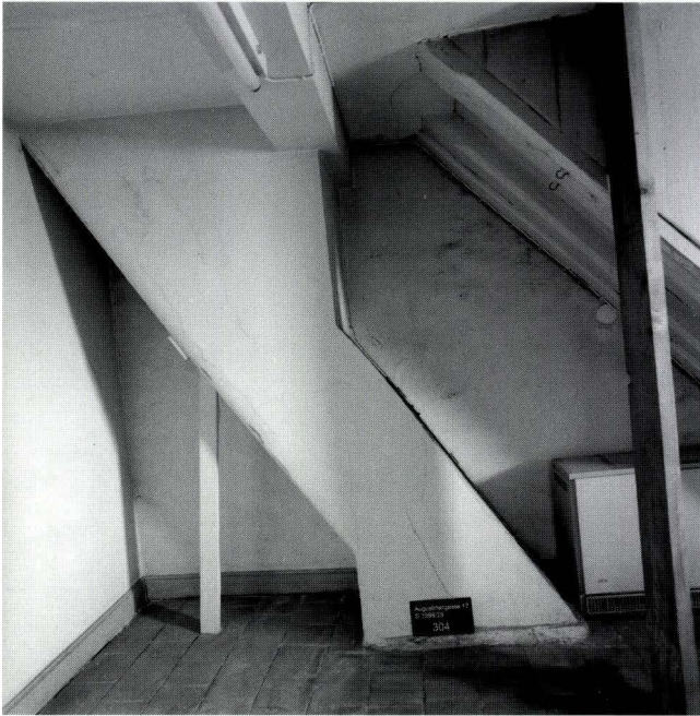
Abb. 7 Vorderhaus, 3. OG: Rückwärtiger Raum an der nördlichen Brandmauer zu Nr. 15. Vor der Blockstufentreppe (rechts oben) verläuft das Kamin von der weiter hinten liegenden Längswand im unteren Geschoss schräg gegen die mittlere Gebäudeachse in den Dachstock. – Foto: Basler Denkmalpflege.
