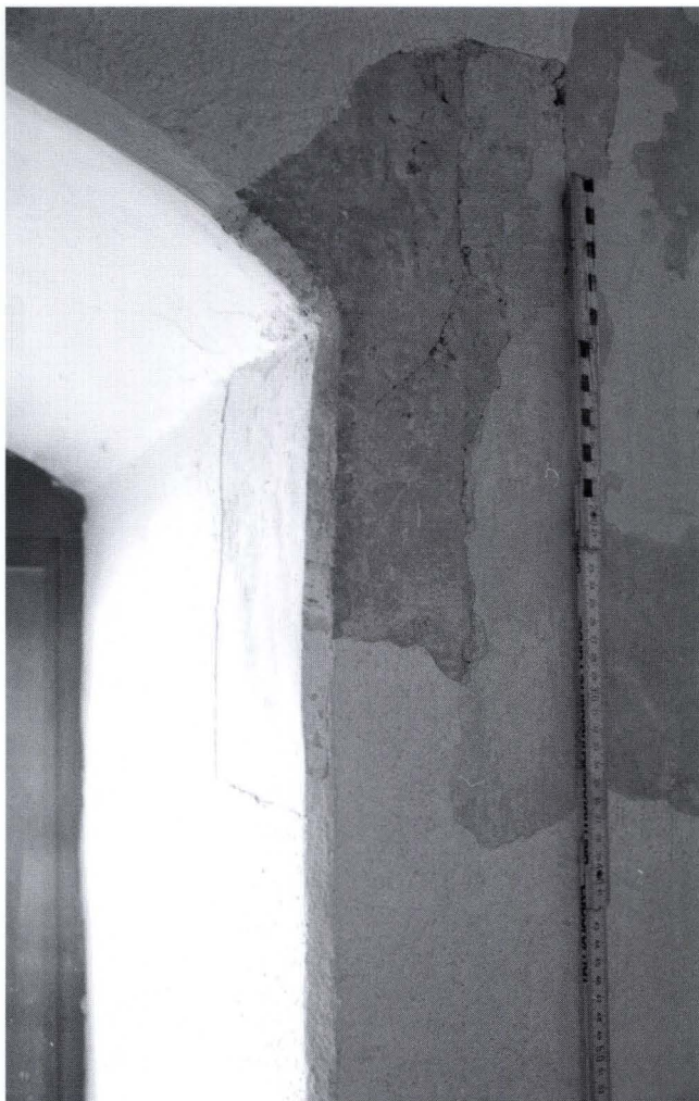
Abb. 30 Hinterhaus, 1. UG: Originalfenster des 14. Jhs. Die schmale Fase an der Leibungskante entspricht der Ausführung bei den ursprünglichen Hoffenstern des Vorderhauses (1363). – Foto: Basler Denkmalpflege.
