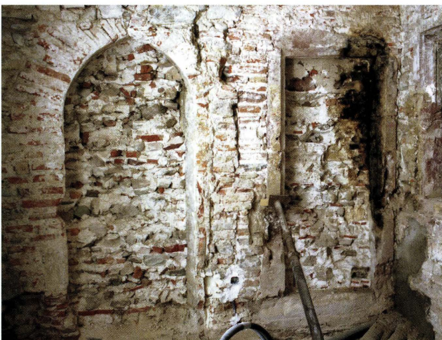
Abb. 29 Brandmauer Süd hinter der Hoffassade des Vorderhauses, 1. OG. Türdurchbrüche zum Nachbarhaus (Augustinergasse 19). Die Rundbogenöffnung links ist älter als die Türe rechts. – Foto: Basler Denkmalpflege.
