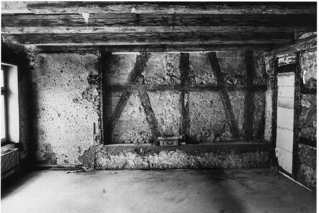
Abb. 6. Teil der östlichen Brandmauer im zweiten Obergeschoss von Haus Webergasse 26. Ältere Fachwerkmauer (6), davor Teile der jüngeren Brandmauer (7). – Foto: BaDpfl., B 569–4.
