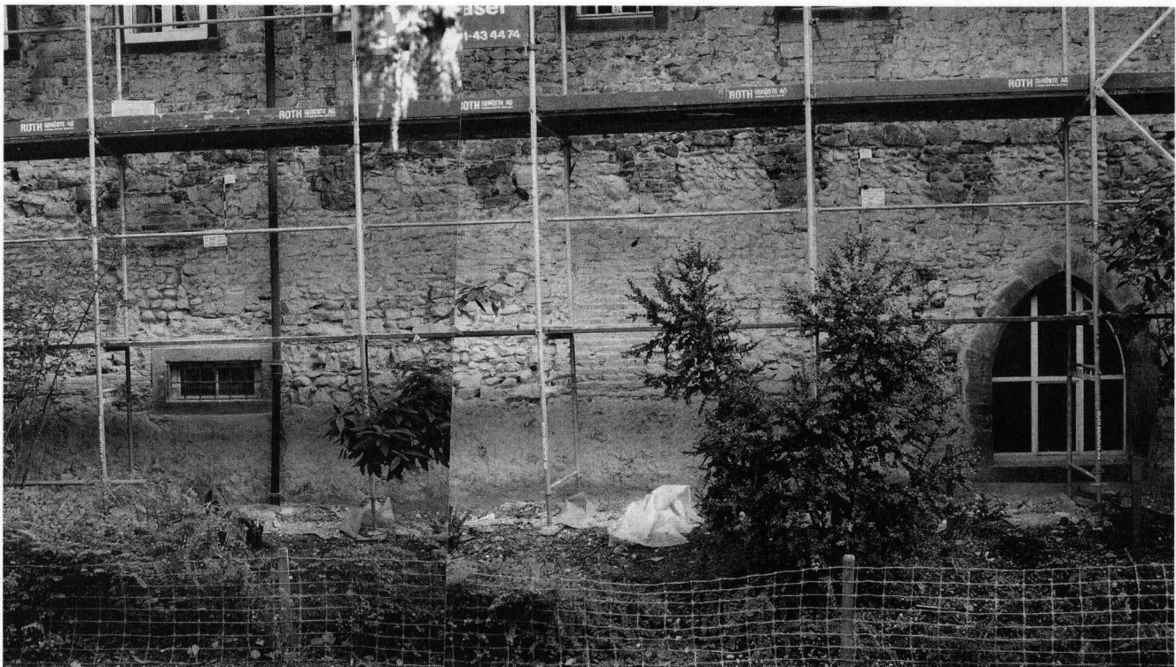
Abb. 3. Ein Teil der freigelegten Nordfassade des 70 Meter langen Dormitoriums des Klingentalklosters. Der Zinnenabschluss der alten Stadtmauer ist etwas über der Bildmitte gut zu erkennen. Die 1274 errichtete Fassadenmauer des Kloster-Gründungsbaus sitzt unmittelbar auf der Stadtmauer auf, gleichzeitig wurde auch das breite Spitzbogentor in die Stadtmauer eingebrochen. – Foto: BaDpfl.
