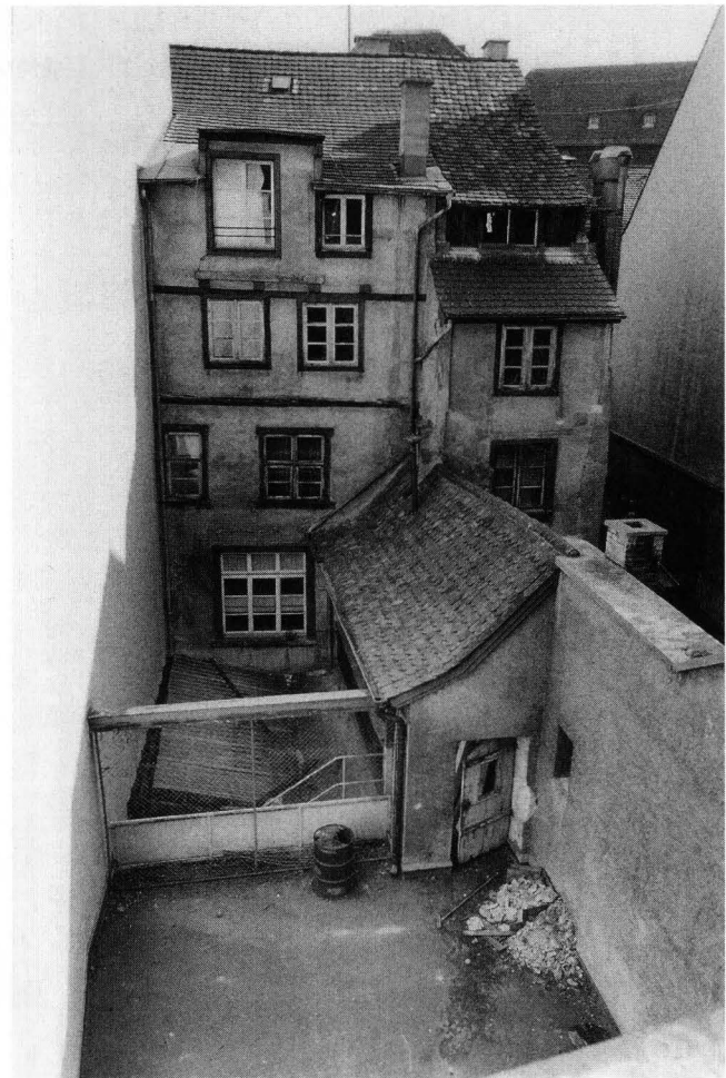
Abb. 2. Gerbergässlein 2, 1989/6. Blick vom Talhang auf die Hinterfassaden der Häuser «zum Schwarzen Turm» (links) und «zum Grünen Stern» (rechts); Zustand vor der Renovierung. Am rechten Bildrand ist die in den dreissiger Jahren entstandene Brandlücke zu erkennen (ehemals Gerbergässlein 4, Haus «zum Ramspach»), die 1989/90 wieder überbaut worden ist. Im Vordergrund ein Rest der Dachterrasse des Hinterhauses (ehemaliger «Schwarzer Turm»), dahinter das Hinterhöflein mit den Gerbergruben aus dem 18./19. Jh. (siehe Abb. 13–17).
