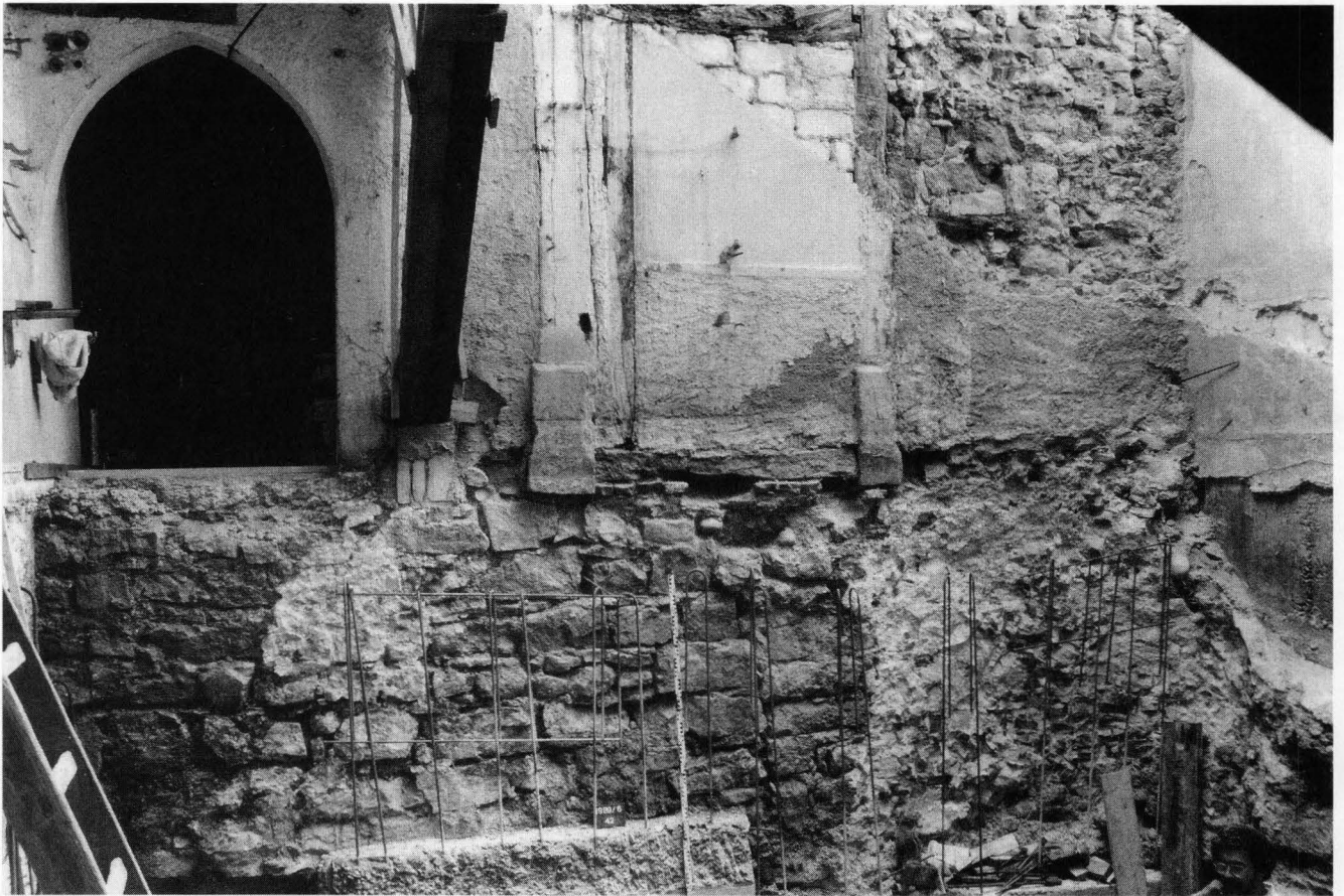
Abb. 7. Gerbergässlein 2 Nord, Hinterhaus. Blick auf die Vorderfassade des «Schwarzen Turms» (vgl. Abb. 6): zu erkennen sind die originale, mit Zement verputzte Eingangstüre des Turms im Erdgeschoss und das Fundament sowie die moderne Unterfangung (darunter). – Foto: AB Nr. 42.
