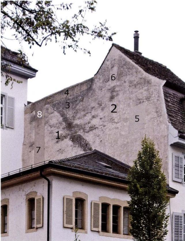
**Abb. 8** Leonhardsgraben 7. Westbrandmauer. Struktur- und Farbunterschiede verschiedener Verputze erlauben es, die Baugeschichte abzulesen:
