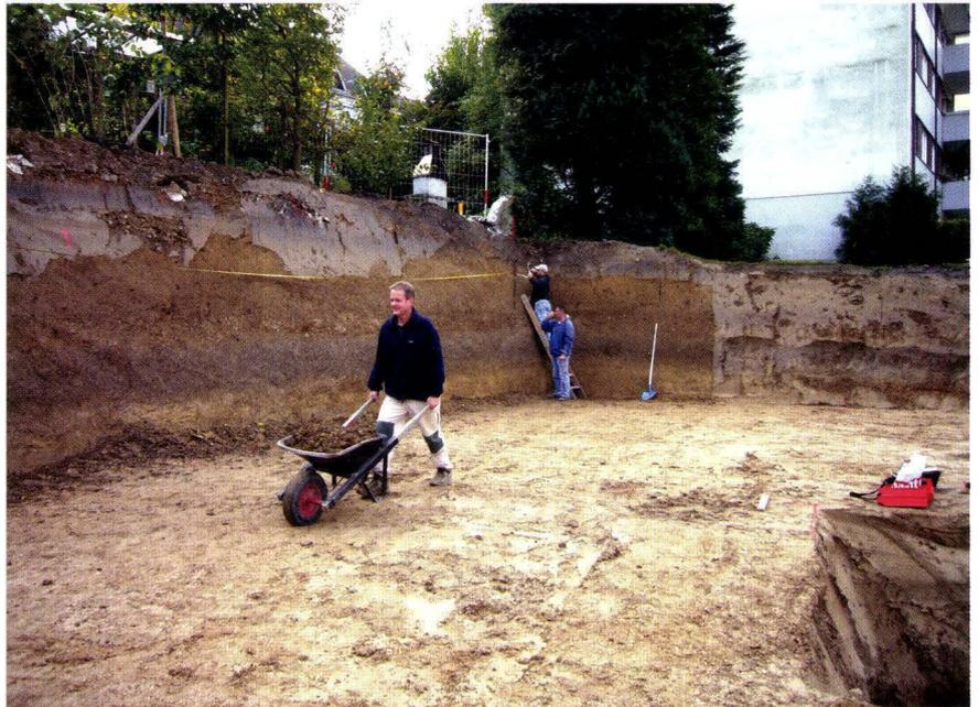
**Abb. 28** Riehen, Gänshaldenweg 10, 2007/59. – Blick in die Südostecke der Baugrube mit den angeböschten Wänden. – Foto: Christoph Matt.
