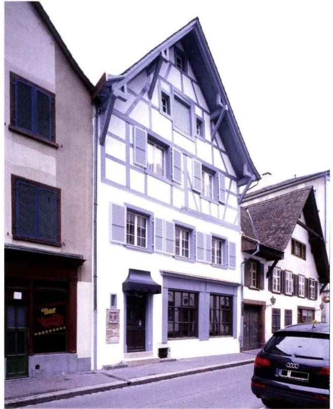
**Abb. 15** Ochsengasse 16. Zustand nach der Renovation 2007. Die beschädigten Oberflächen der Fachwerkkonstruktion wurden mit Brettern kaschiert. Die Verbretterung des Dachhimmels wurde entfernt. Aufgrund von Farbbefunden hat man sich für eine kühle Grautönung der Hölzer, Gewände und Schlagläden entschieden. – Foto: Conradin Badrutt.
