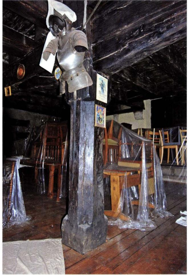
**Abb. 5** Spalenvorstadt 10. Im unteren Keller steht exakt darunter eine gleichartige Holzstütze wie oben in der mittleren Tragachse. – Foto: Bernard Jaggi.
