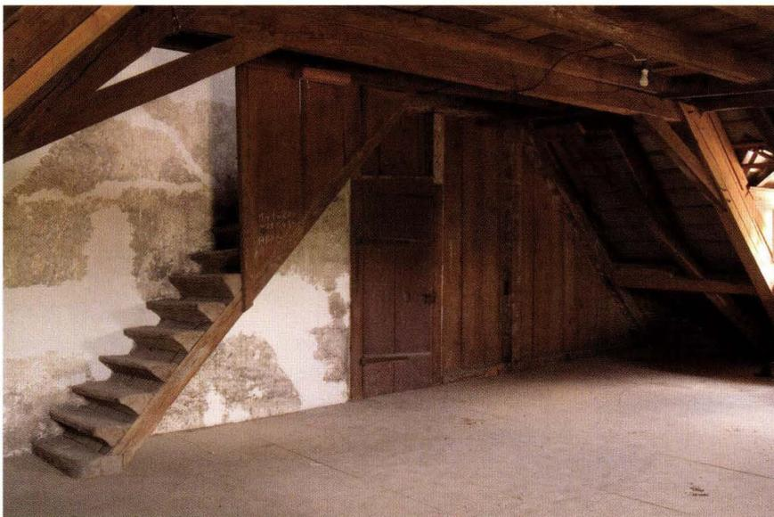
**Abb. 6** Hebelstrasse 7. Teil B, Dachgeschoss. Blick an die einstige Aussenseite der westlichen Giebelwand des Baukörpers A. Die Fachwerkwand steht zur im Erdgeschoss massiven Binnenmauer etwa 75 cm nach aussen versetzt und begrenzte die ursprünglich auskragenden Stockwerke der Obergeschosse. Der vordere Abschnitt (links) wurde erst nach dem Anbau von B ganzflächig verputzt; im hinteren Abschnitt sind Teile des Fachwerks entfernt. – Foto: Conradin Badrutt.
