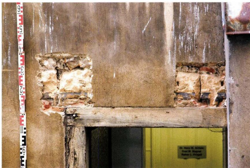
**Abb. 12** Steinenvorstadt 51. Fensterbefund an der Hofseite im 1. OG. Ausschnitt des ehem. Fenstersturzes der rechten, dreiteiligen Fensteranlage. An der stark beschädigten Steinoberfläche haben sich die Ansätze der Mittelpfosten auf der zurückgesetzten Falzoberfläche besser erhalten. – Foto: Benjamin Fischer.
