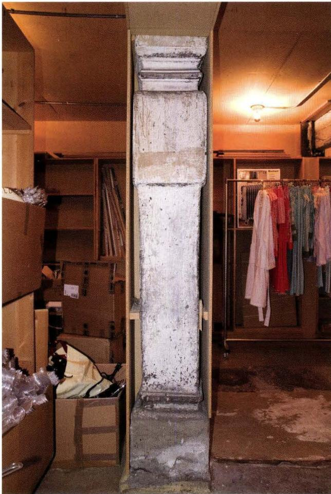
**Abb. 7** Steinenvorstadt 51. Keller. Der profilierte Holzpfosten in der Mitte des grösseren Kellers rechts stammt nach Ausweis der Dendrochronologie aus einer Umbauphase Ende 17. / Anfang 18. Jahrhundert. – Foto: Benjamin Fischer.
