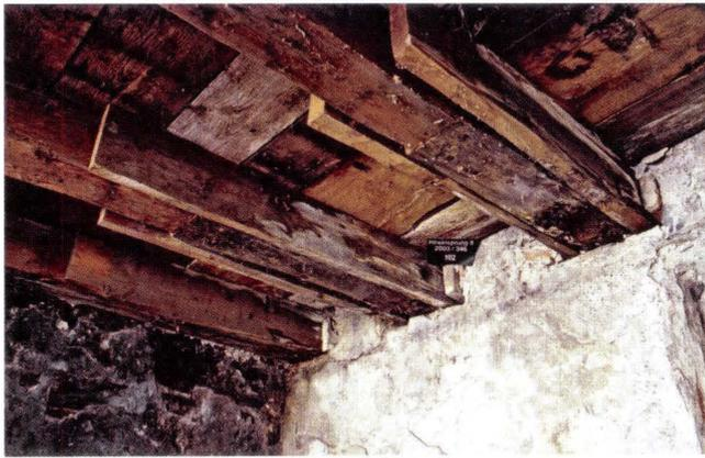
**Abb. 11** Rheinsprung 8. 1. Obergeschoss, Raum 102. Wegen der feuchten Wand faulten zuerst die Balkenköpfe in der Mauer ab und später auch die eingegrateten Eichenbretter. Die seitlichen Aufdoppelungen in Eiche scheinen bis heute intakt. – Foto: Matthias Merki.
