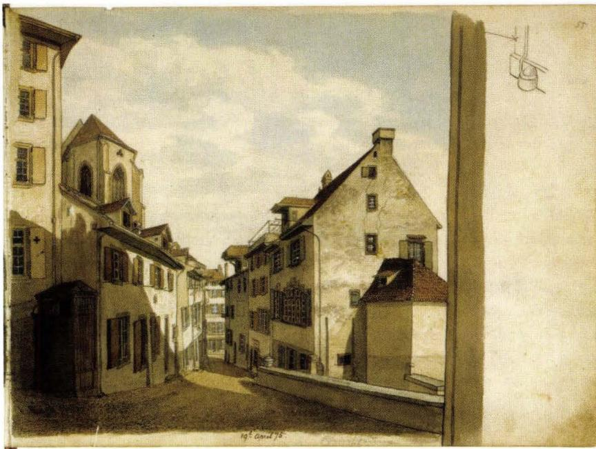
**Abb. 4** Rheinsprung 10. Die Aquarellskizze zeigt das Haus mit durchgehender Traufe, ein Hinweis, dass die grössere Lukarne (im unteren Hausteil) 1875 nicht mehr als Aufzugsgaube diente. – Aquarellskizze aus dem Skizzenbuch von Johann Jakob Schneider, unten im Bild datiert: 19. April 75.
