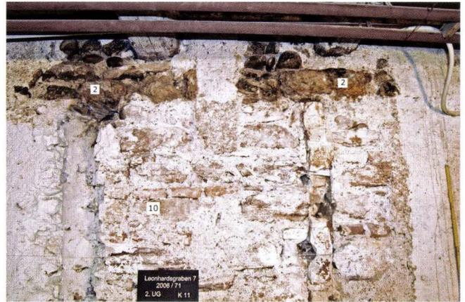
**Abb. 23** Leonhardsgraben 7. Hinterhaus, 2. Untergeschoss. Spätmittelalterlicher Keller. Blick auf den mittleren Bereich der Ostwand. 2: Fundamentzone der originalen Ostbrandmauer. 10: Unterfangungsmauer. Links der Abdruck eines verloren gegangenen Unterfangungsspriesses. An dessen oberem Abschluss sind Abdruckreste horizontaler Brettchen in der Funktion von Kämpferhölzchen erhalten. Rechts: zugemauerter Abdruck eines Spriesses. – Foto: Urs Bertschinger.
