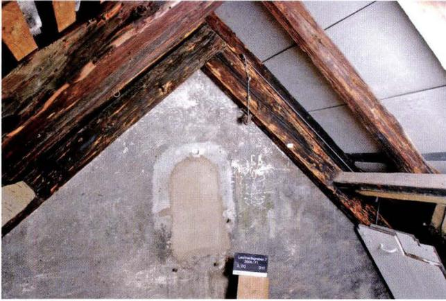
**Abb. 11** Leonhardsgraben 7. Vorderhaus. Westliche Giebelmauer aus massivem Mauerwerk, mit zugemauertem kleinem Fenster (etwa 65 cm hoch und 35 cm breit) – siehe auch Abb. 8, Pos. 6. Der Binder mit eingezapften Riegeln und aufliegenden Sparren hat keine konstruktive Verbindung mit dem Mauerschild – im Gegensatz zur Situation am Ostgiebel: Dies sind deutliche Hinweise, dass die Westbrandmauer älter als das Vorderhaus von Leonhardsgraben 7 ist. – Foto: Matthias Merki.
