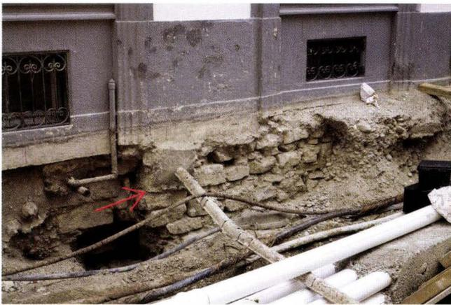
**Abb. 4** Freie Strasse 25. Hauptfassade. Bausituation vor Ausschachtung des Trottoirlifts. Die vorstehende barocke Mauer des rechten (südlichen) Fassadenteils endet gegen Norden mit einer vertikalen Kante (Pfeil). Sie diente wahrscheinlich der Verstärkung des spätmittelalterlichen Fundaments der Strassenfassade. – Foto: Basler Denkmalpflege, Matthias Merki.
