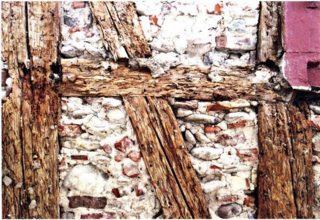
**Abb. 10** Ochsengasse 16. Der schlechte Zustand des Fachwerks von 1615 auf der Höhe des 2. OG. Bei den Überblattungen und Verzapfungen ist die Holzsubstanz stark angegriffen. Die Ausfachungen bestehen aus einer Mischung von Backsteinresten, Wacken und Kalkbruchsteinen. Links im Bild der Mittelpfosten von 1615. Original dazugehörige Verputzreste sind keine vorhanden. – Foto: Stephan Tramèr.
