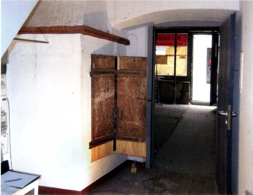
**Abb. 8** Spalenberg 30. Sicht vom hofseitigen Raum Richtung Strasse, mit Blick an die Quermauer, an die sich die Kaminkammer anfügt. Über der Türöffnung ist der gewölbeartig ausgebildete Schacht sichtbar, worin der Rauch zur gegenüberliegenden Brandmauer geführt wurde. – Foto: Hans Ritzmann.
