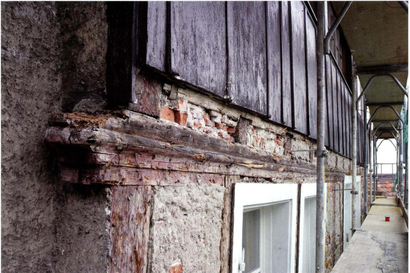
**Abb. 10** Spalenvorstadt 10. Hinterfassade. Oberer Fachwerkstock, unterhalb der Aufstockung (2. OG). Das über einer Abfaltung ansetzende Karniesprofil mit Wulst darüber bildet am seitlichen Ende der Fachwerkfassade eine Verkröpfung. – Foto: Bernard Jaggi.
