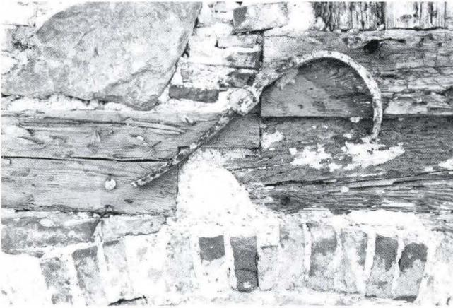
**Abb. 13** Ochsengasse 16. Der gekürzte Rähm- und Schwellenbalken von 1615 und der 1810 angefügte Schwellbalken (links) werden von einer Eisenklammer zusammengehalten. Darunter einer der Entlastungsbogen der Fenster des Umbaus von 1852. – Foto: Stephan Tramèr.
