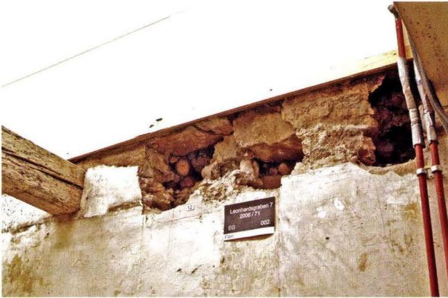
**Abb. 25** Leonhardsgraben 7. Hinterhaus, EG. Ost-Brandmauer. Zwei der in die Brandmauern eingebrochenen Deckenbalken datieren ins Jahr 1364 (Fälldatum). Demnach sind beide Brandmauern älter. Vom ursprünglichen Glattputz waren im Zwischenbodenbereich noch Bruchstücke erhalten. – Foto: Matthias Merki.
