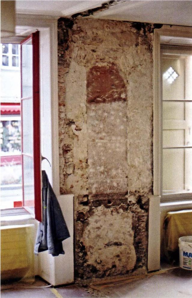
**Abb. 2** Spalenvorstadt 10. Blick auf die freigelegte strassenseitige Fassadenmauer im EG. Im Mauerwerk zwischen zwei Fenstern hat sich ein Fensterpfeiler aus Sandsteinquadern erhalten. Die seitlich angelegten Fensteröffnungen waren von einem Innensturz aus Backstein-Stichbögen überwölbt. Der Brüstungsbereich ist in Bruchstein gemauert. Die Aufnahme entstand im Zusammenhang mit einer kleinen Innenuntersuchung im Oktober 2002. – Foto: Archiv Basler Denkmalpflege.
