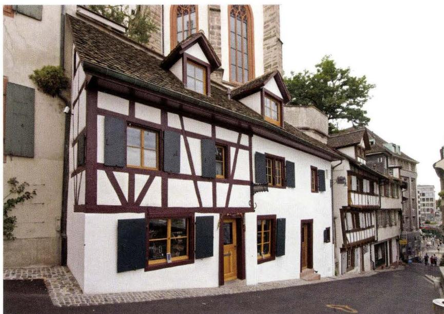
**Abb. 1** Rheinsprung 10. Die obere Türe neben dem flachen Wandpfeiler im Erdgeschoss, der zum unteren Hausteil abgrenzt, wurde anstelle eines in jüngster Zeit zugemauerten Fensters neu eingebrochen. – Foto: Matthias Merki.
