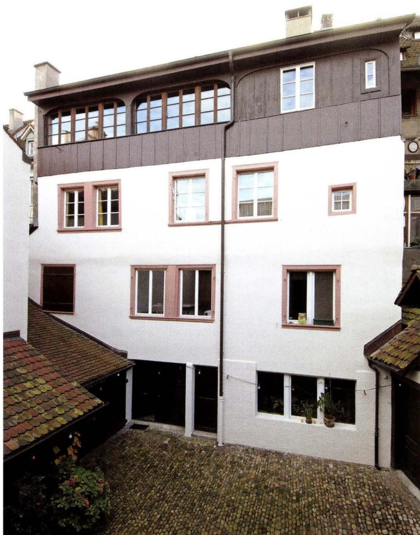
**Abb. 1** Spalenvorstadt 10. Rückfassade mit vier Geschossen. Das unterste Geschoss liegt auf der Rückseite auf der Höhe des ersten Kellers, das strassenseitige Erdgeschoss auf der Höhe des ersten OG. Die Front entstand anlässlich einer rückwärtigen Erweiterung als Fachwerkkonstruktion vor der älteren Fassadenmauer. Das oberste Geschoss gehört zu einer späteren Aufstockung. – Foto: Bernard Jaggi.
