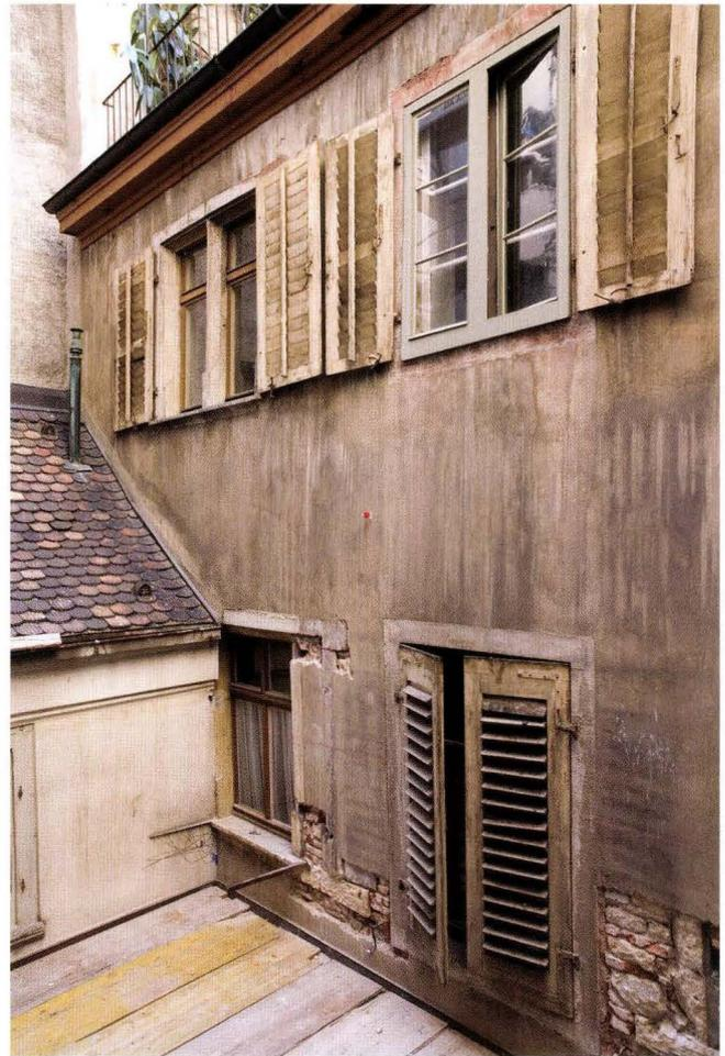
**Abb. 8** Steinenvorstadt 51. Hofseite, 1. und 2. OG. Der Erdgeschossenteil ist nicht sichtbar, da der Laden in jüngster Zeit zum Hof hin ausgebaut wurde. Seitlich schliesst ein älteres Flügelgebäude an. Über dem 2. OG ist die Terrasse, die im Rahmen der Fassadenaufstockung von 1890 angelegt wurde, ansatzweise zu erkennen. Um die Fenster des 1. OG wurden zu Untersuchungszwecken Verputzfreilegungen durchgeführt. – Foto: Benjamin Fischer.
