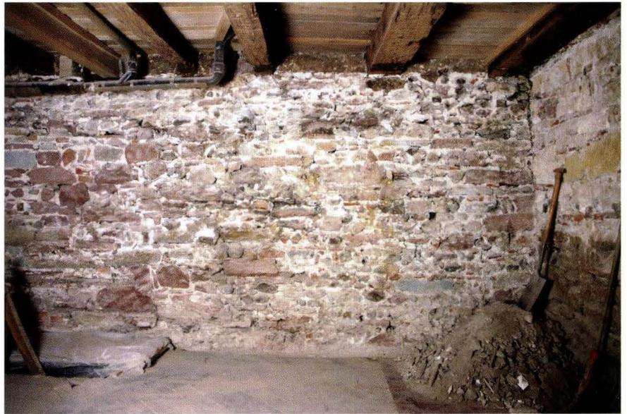
**Abb. 3** Malzgasse 1. Die freigelegte Nordbrandmauer mit grossen Partien aus rotem Buntsandstein und vereinzelt Flusskieseln wurde sekundär anstelle einer Riegelkonstruktion unter einer Vorkragung in der Zeit zwischen 1650 und 1750 erstellt. – Foto: Hans Ritzmann.
