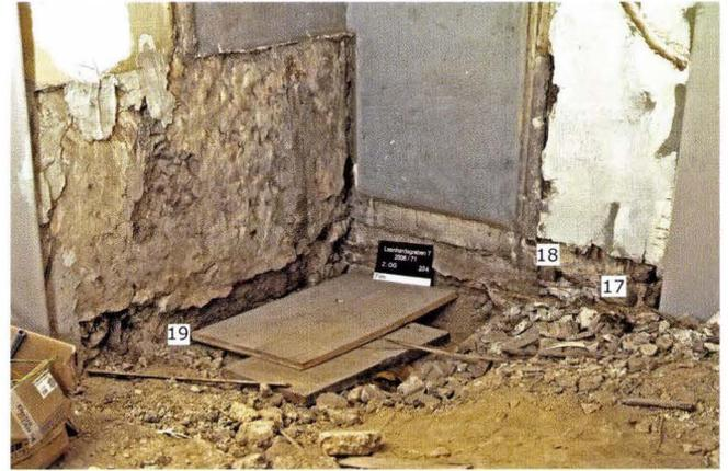
**Abb. 26** Leonhardsgraben 7. Hinterhaus, 2. OG. Nordwestecke. Rechts die Nordmauer aus Bruchsteinen und Kieseln (17). 18: Eingebrochene Türe. Links die Westbrandmauer (19), wahrscheinlich im Eckverband mit der Nordmauer, was jedoch wegen der eingebrochenen Türe auf den ehemaligen Hof von Spalenberg 61 nicht nachgewiesen werden konnte. – Foto: Matthias Merki.
