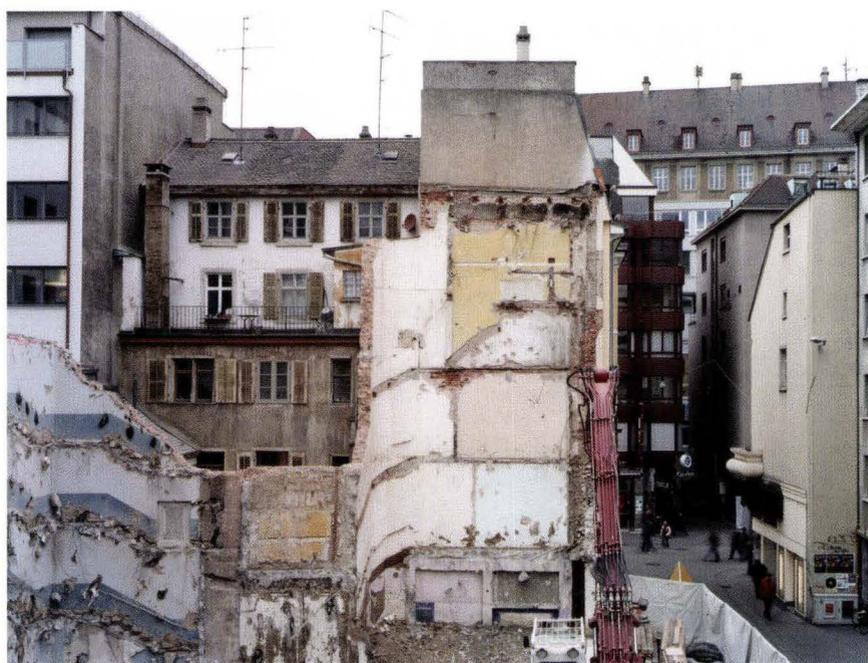
**Abb. 2** Steinenvorstadt 51. Baustelle nach dem Abbruch des Kino «Hollywood». Die Aufnahme von 2006 gibt den Blick frei auf die Rückseite des Gebäudes Steinenvorstadt 51 mit der zurückgesetzten zweigeschossigen Aufstockung. Die schwach geneigte Dachfläche zieht zur alten Firsthöhe. – Foto: Erik Schmidt.
