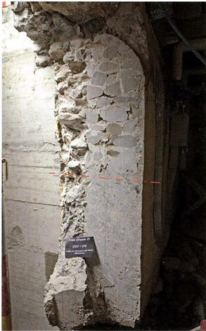
**Abb. 3** Freie Strasse 25. Hauptfassade. Situation nach Ausbrechen und Ausfräsen der Mauer. Mauerquerschnitt gegen Norden. Hier zeichnet sich deutlich die Unterkante des spätmittelalterlichen Fundaments aus Flusskieseln ab (rot markiert). Die darunter liegende Unterfangung von 1970 besteht aus reinem Beton. – Foto: Matthias Merki.
