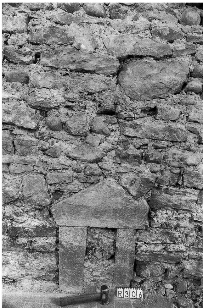
Abb. 19 Bäumleingasse 14. Fensterschlitz oder Nische des Nachbarhauses im 2. Obergeschoss an der Ostmauer. – Foto BaDpfl B780-11.
