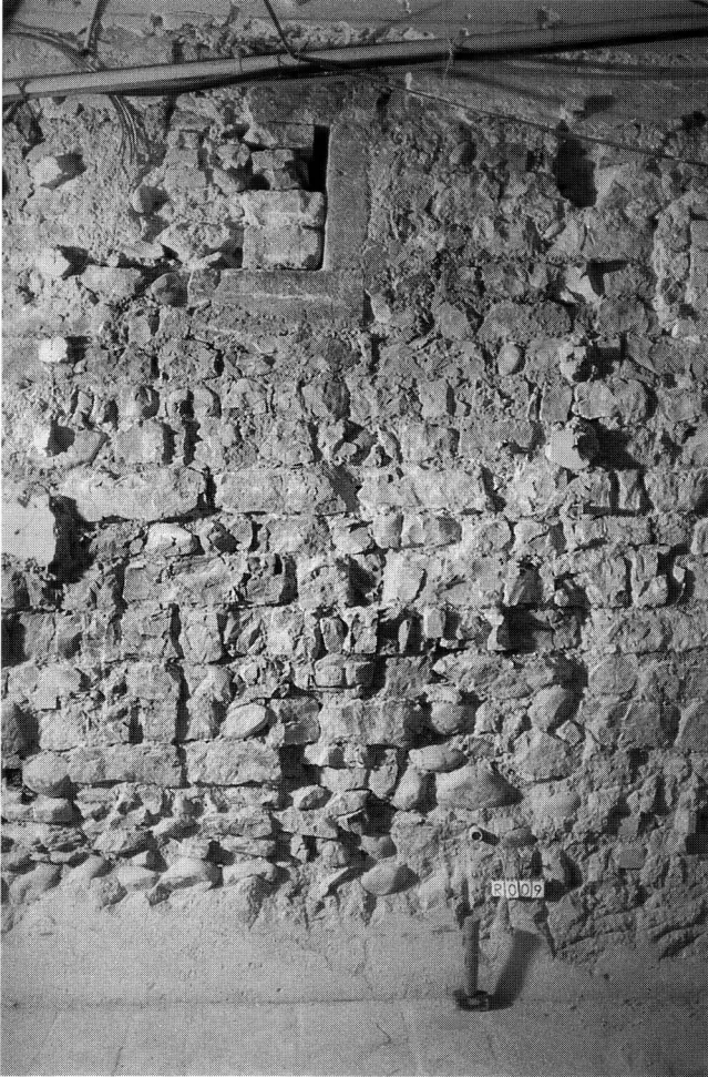
Abb. 5 Bäumleingasse 14. Mauerwerk des Kernbaus I mit dem ehemals vergitterten Fenster im Erdgeschoss. – Foto: BaDpfl M B777–2.
