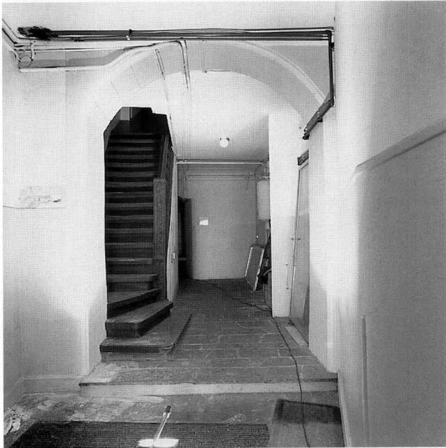
Abb. 15 Bäumleingasse 14. Innerer Portalbogen und Treppe im Erdgeschoss. – Foto: BaDpfl M 454–8.
