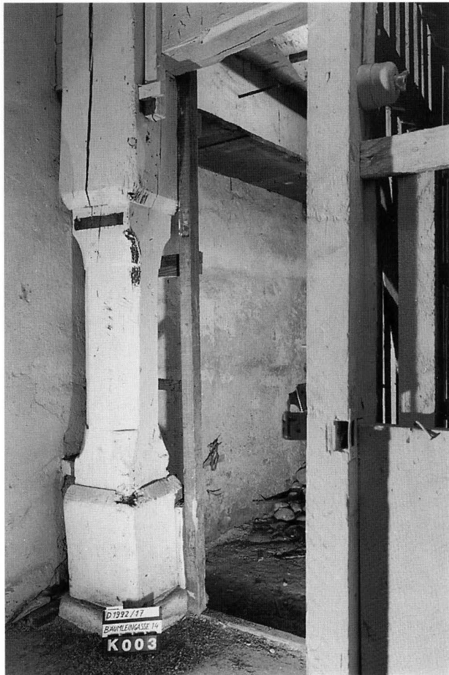
Abb. 11 Bäumleingasse 14. Holzstütze im Keller. Dendrodatiert 1460 oder kurz danach. – Foto: BaDpfl B 716–18.
