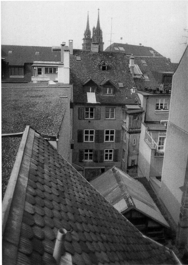
Abb. 21 Bäumleingasse 14. Das Haus vom Hinterhof aus gesehen. – Foto: BaDpfl B776–7.
