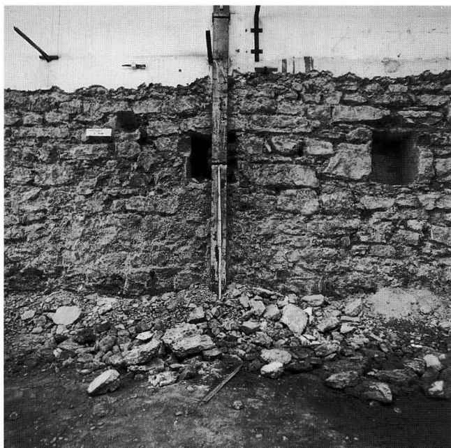
Abb. 9 Bäumleingasse 14. Ausschnitt aus der Ostmauer des ehemaligen Hinterhauses oder Ökonomiebaus. – Foto: BaDpfl M 586–9.
