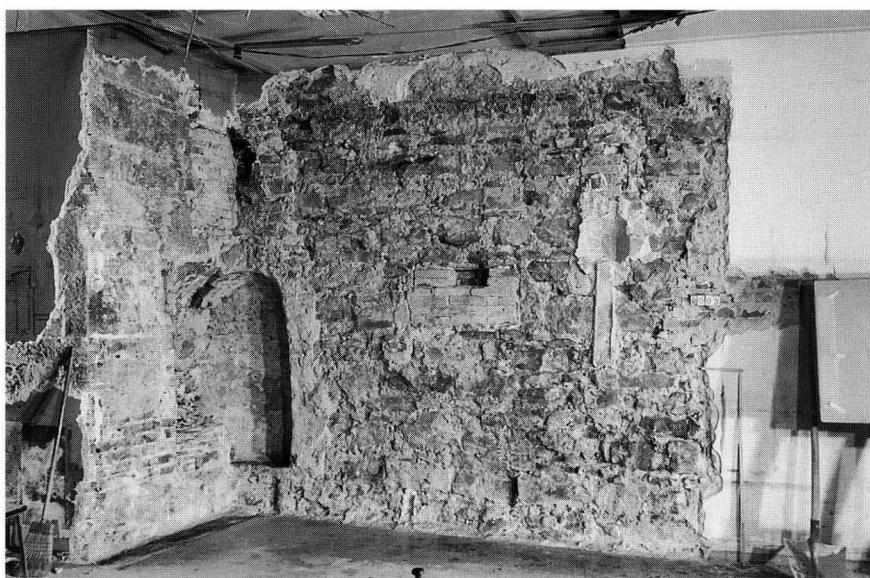
Abb. 14 Bäumleingasse 14. Westmauer im Erdgeschoss mit Ofenfeuerloch in der Ecknische. – Foto: BaDpfl B765–3.
