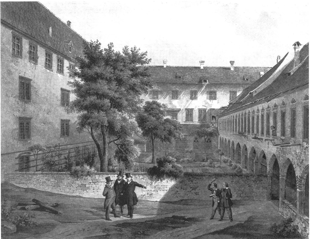
Abb. 38. Aquarell von Constantin Guise, 1849 (vermutlich gestützt auf ältere Vorlagen; StAB: Bildersammlung Wack. G. 103). Kreuzganghof, Blick gegen Osten: links die aufgestockte Südfassade des Kirchenseitenschiffs; hinten der Osttrakt des Klosters, rechts der Südflügel des Kreuzgangs; die Gartenmauer im Vordergrund vermutlich eine Erinnerung an einen einstigen Westflügel.
