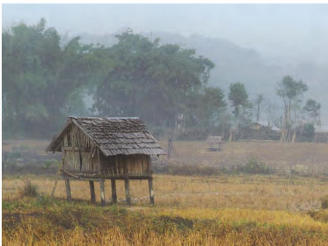
Abb. 80 Abgehobener Speicherbau auf sechs Pfosten, Laos.
