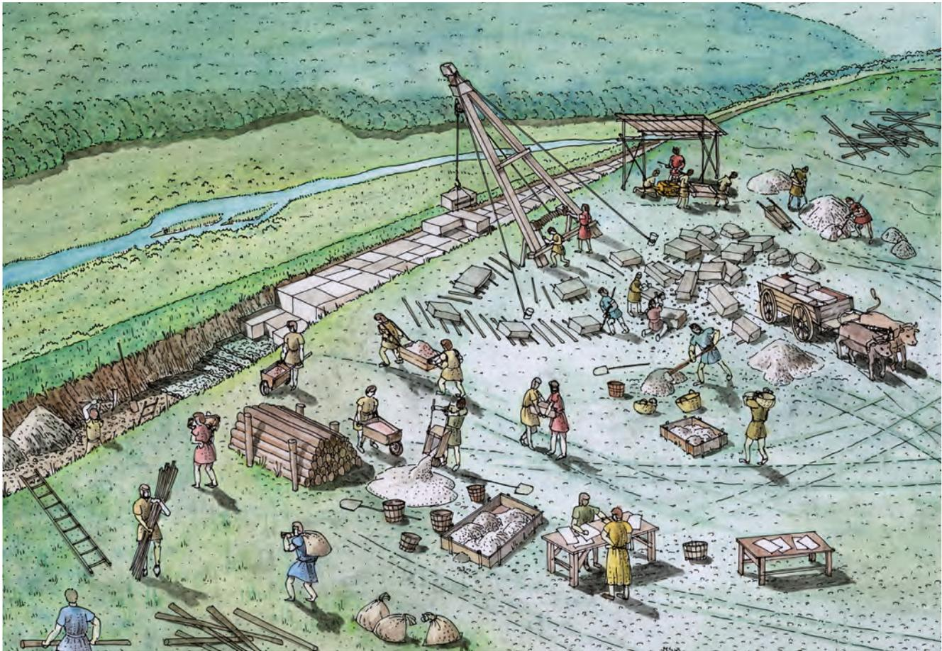
**Abb. 229** Martinsgasse 6+8 (2004/1). Rekonstruktion der Baustelle der westlichen Wehrmauer anhand der Befunde zum Bauhorizont SR I bh (vgl. Abb. 37). Gesichert sind der Mörtelmischplatz (Bildmitte rechts), das Löschen von Brantkalk (Bildmitte rechts und unten), das Zurechtschlagen der Bausteine (Bildmitte) sowie die Esse (oben, überdacht – nicht am originalen Standort). Die Zulieferung der Baumaterialien erfolgte von Osten (Bild rechts). Blick von Südosten.
