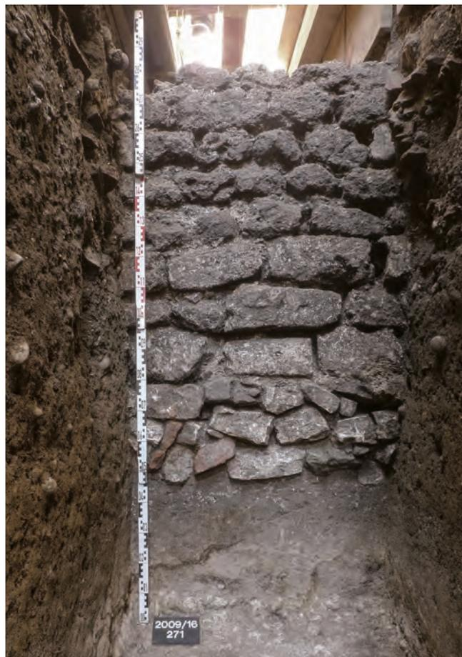
**Abb. 174** Martinskirchplatz. Befundzone 2. Blick von Süden gegen Mauer SR II mr 1. Die untersten drei Lagen bilden das trocken gelegte Fundament, die folgenden drei Lagen das gemörtelte Fundament. Darauf folgen fünf Lagen Aufgehendes aus Handquadern. Rechts: Lage des Befundes.
